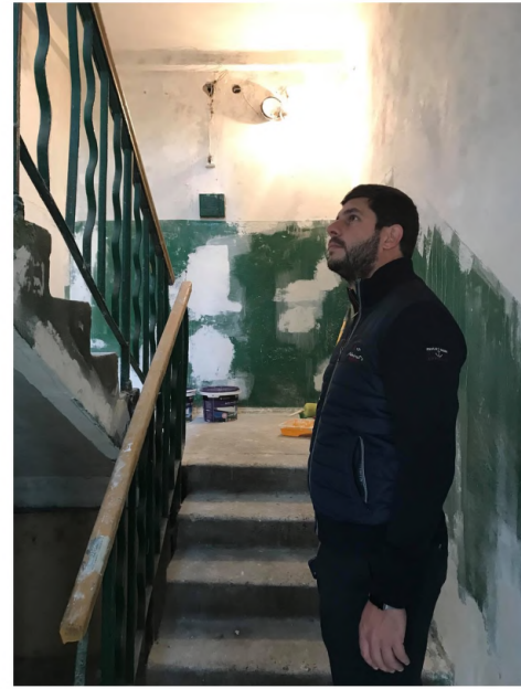
Контроль ремонтних робіт в житлових будинках Controlling repair works in houses
