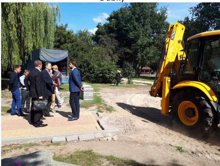
Перевірка виконання ремонтних робіт в парку «Веселка» Checking repair works in park "Veselka"
