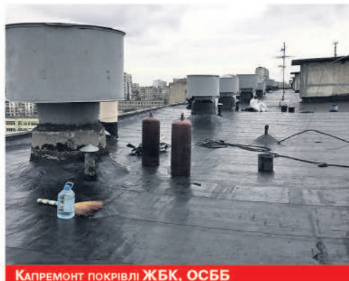
КАПРЕМОНТ ПОКРІВЛІ ЖБК, ОСББ
