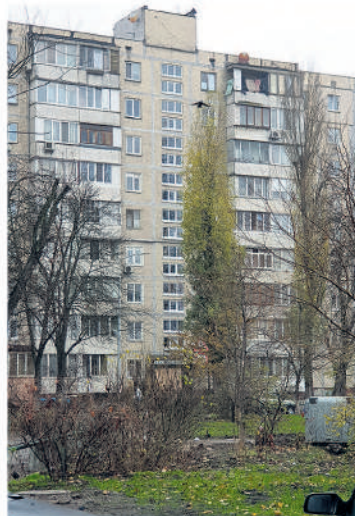
ЗАМІНА ВІКОН (ДВЕРЕЙ) ЖБК, ОСББ
