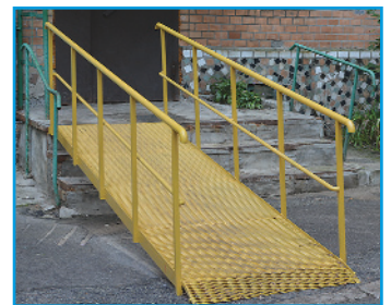
Вул. Котельникова, 46: відремонтовано систему гарячого та холодного водопостачання у підвальному приміщенні, встановлено нові енергозберігаючі вікна на всіх сходових клітинах, встановлено пандус
