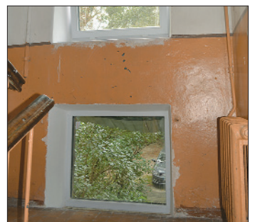
Вул. Івана Крамського, 4: встановлено нові енергозберігаючі вікна на всіх сходових клітинах та капітально відремонтовано покрівлю
