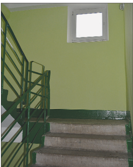
Вул. Жмеринська, 36: у 4 під'їзді виконано ремонт сходових клітин
