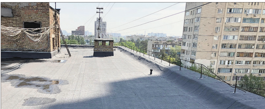
Вул. Львівська, 12: виконано капітальний ремонт покрівлі
