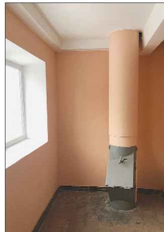
Вул. Львівська, 1: виконано капітальний ремонт сходових клітин у 2 та 3 під'їздах
