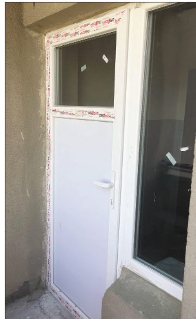
Вул. Святошинська, 4: на сходових клітинах встановлено 17 нових енергозберігаючих дверей
