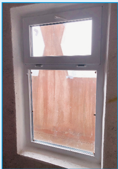
Вул. Якуба Коласа, 27-В: встановлено 32 нових енергозберігаючих вікна на всіх сходових клітинах
