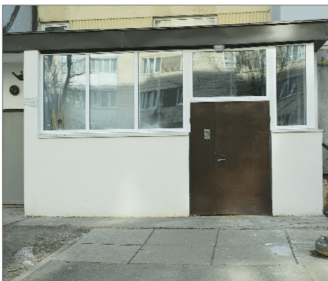
Вул. Верховинна, 5а: виконано капітальний ремонт вхідної групи у 1 та 2 під'їздах
