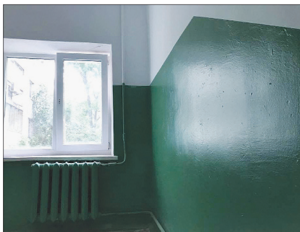
Вул. Котельникова, 46: у 1 під'їзді виконано капітальний ремонт сходових клітин
