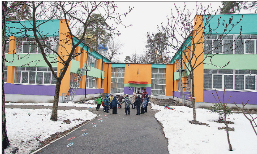
У найстарішому в окрузі дитячому садку №60 по вул. Львівська, 32 теж зробили капітальний ремонт
