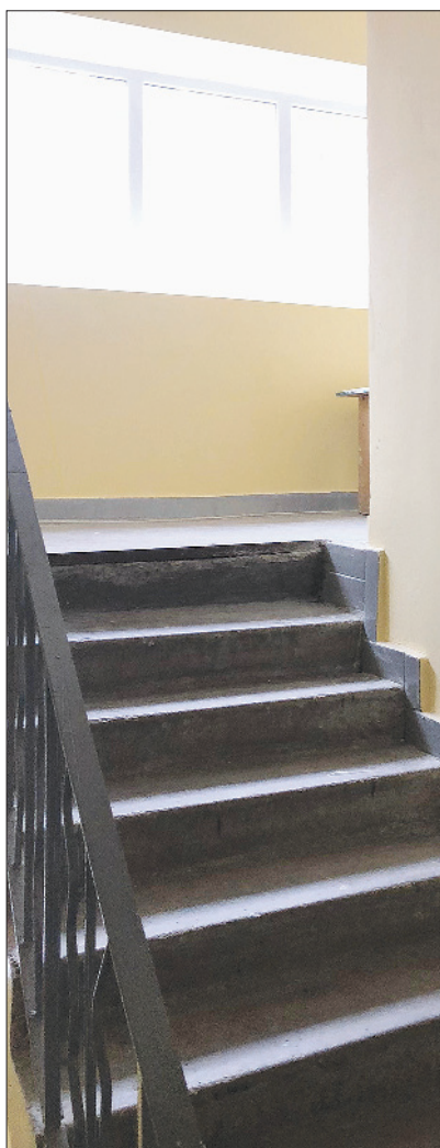
Вул. Святошинська, 6: у 3 та 4 під'їздах виконано капітальний ремонт сходових клітин
