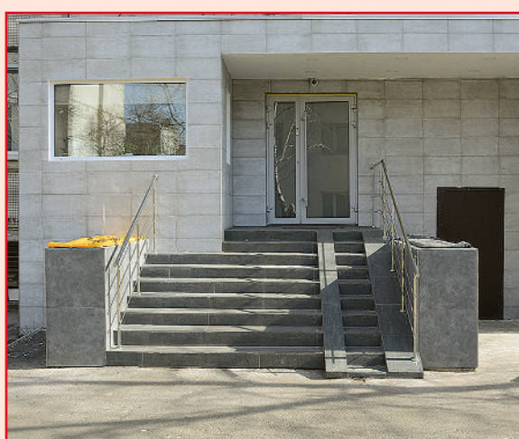
Пр-т Перемоги, 93: виконано капітальний ремонт вхідної групи
