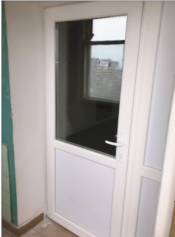
Вул. Героїв Космосу, 13: на сходових клітинах встановлено 18 нових енергозберігаючих дверей
