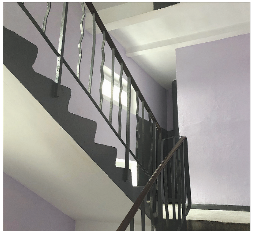
Вул. Котельникова, 12: виконано капітальний ремонт сходових клітин
