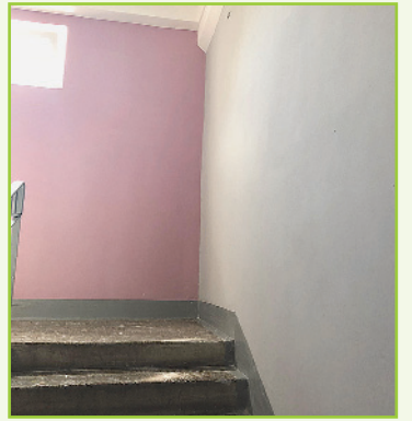
Вул. Якуба Коласа, 29: у 3 та 4 під'їздах виконано капітальний ремонт сходових клітин
