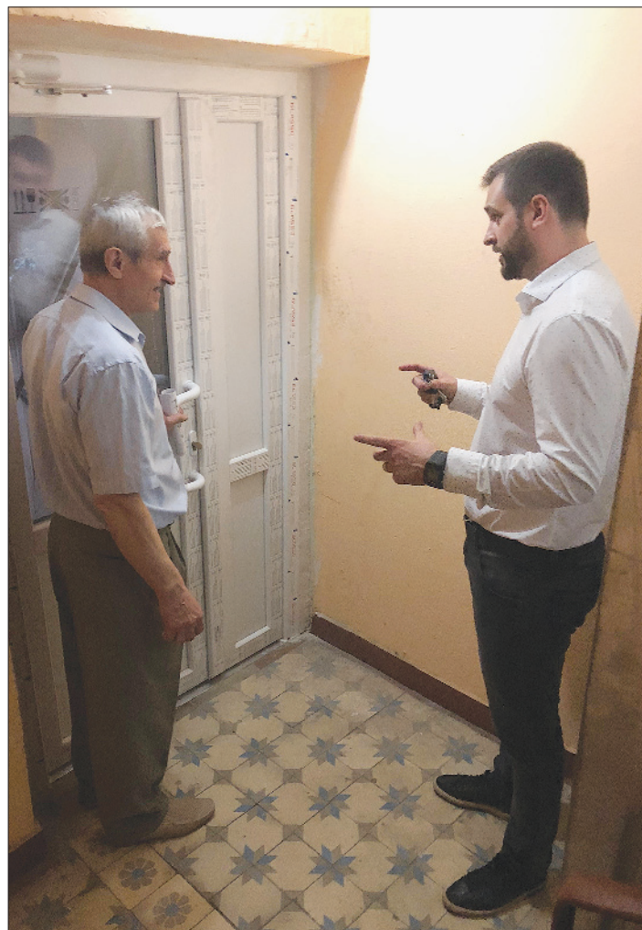
Вул. Героїв Космосу, 15: на сходових клітинах встановлено 18 нових енергозберігаючих дверей
