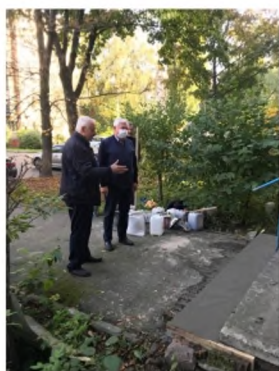
Ремонт вхідних груп
