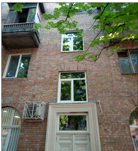
Нові металопластикові вікна, вул. Глазунова, 3
