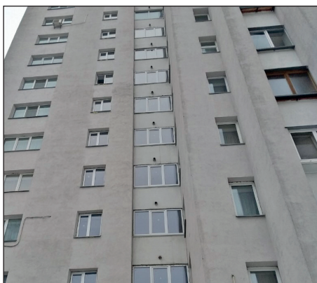
Заміна вікон на просп. Маяковського, 97/15
