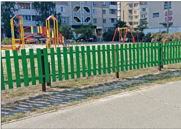
Встановлення парканчику на вул. Милославській, 33
