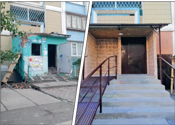
Ремонт вхідної групи на вул. Милославська, 31-Б (до та після)
