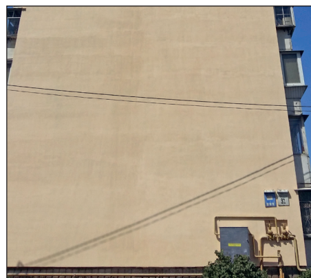
Утеплення фасаду на вул. Милославській, 31
