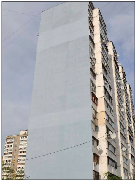
Утеплення фасаду на вул. Милославська, 33
