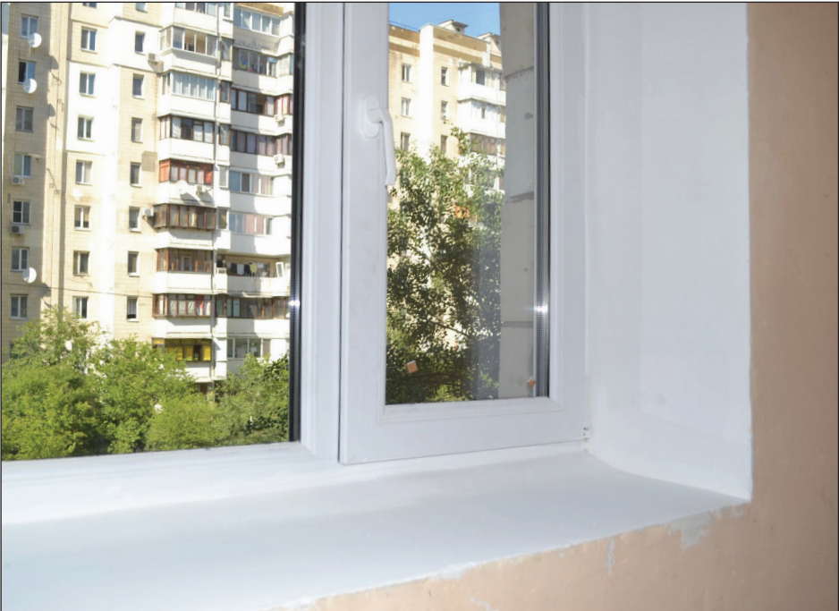
Заміна вікон на просп. Маяковського, 95-Б
