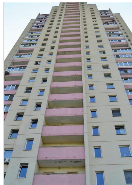
Заміна вікон на вул. Милославська, 4-А
