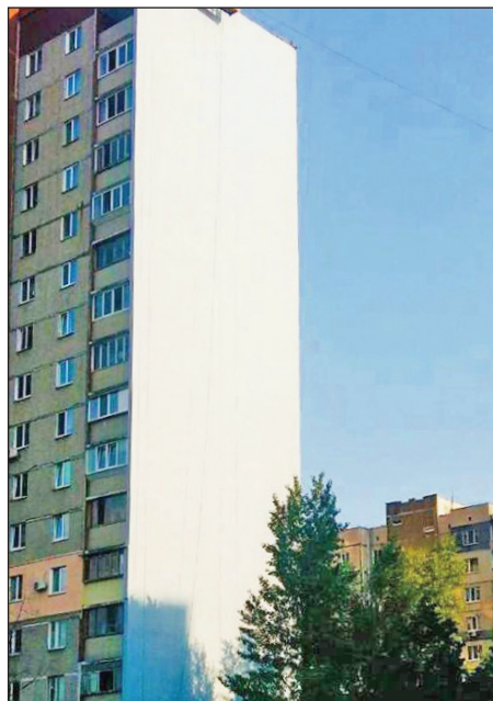
Утеплення фасаду на вул. Милославська, 25
