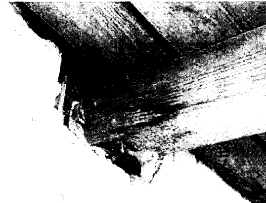
Рисунок 3.15 Сліди замокання на крокві з дерев'яного бруса.
