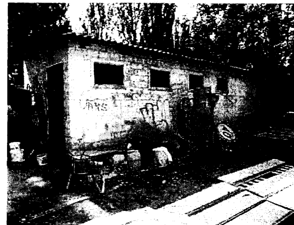
Рисунок 4. Загальний вигляд будівлі №9.1 (велика) з сторони заднього фасаду.
