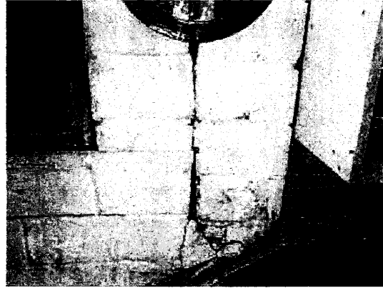
Рисунок 3.1. Наскрізна тріщина в стіні зліва від входу в будівлю
