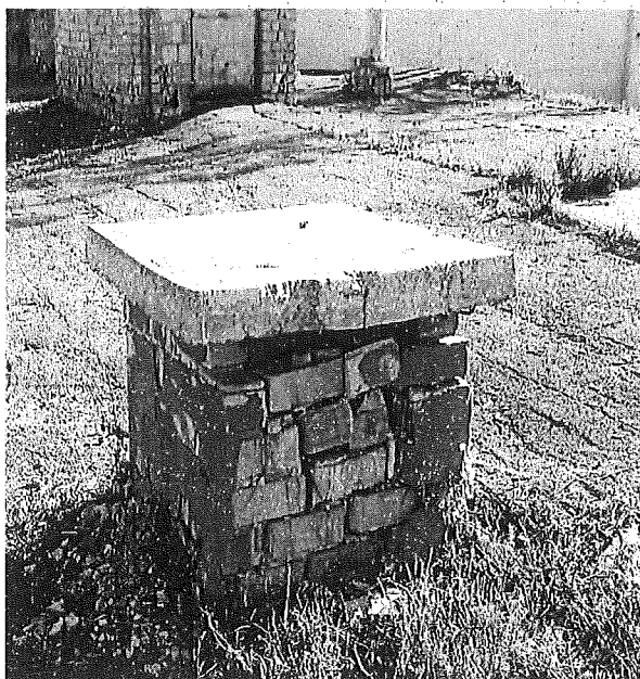
Рис.5. Випадіння цегли з вентиляційних оголовків
