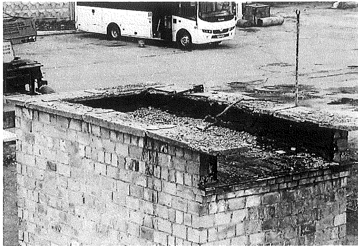
Рис.7. Руйнування, пориви, відшарування руберойду
